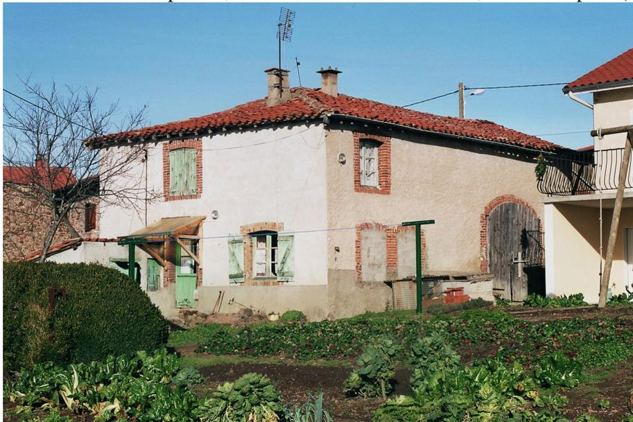
Toiture à 4 pans en tuiles canal, encadrement des baies en briques (Le Bourg)
